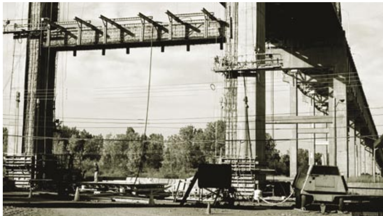
Travaux sur les piles du pont Honoré-Mercier à Montréal
