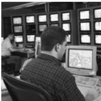
Salle de contrôle des caméras de surveillance vidéo et des feux de voies des ponts Jacques-Cartier et Champlain à Montréal
