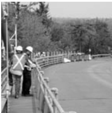
Travaux au pont international des Mille-Îles
