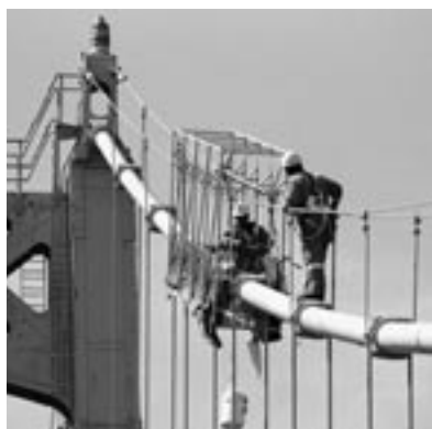
Travaux en hauteur au pont international de la Voie maritime
